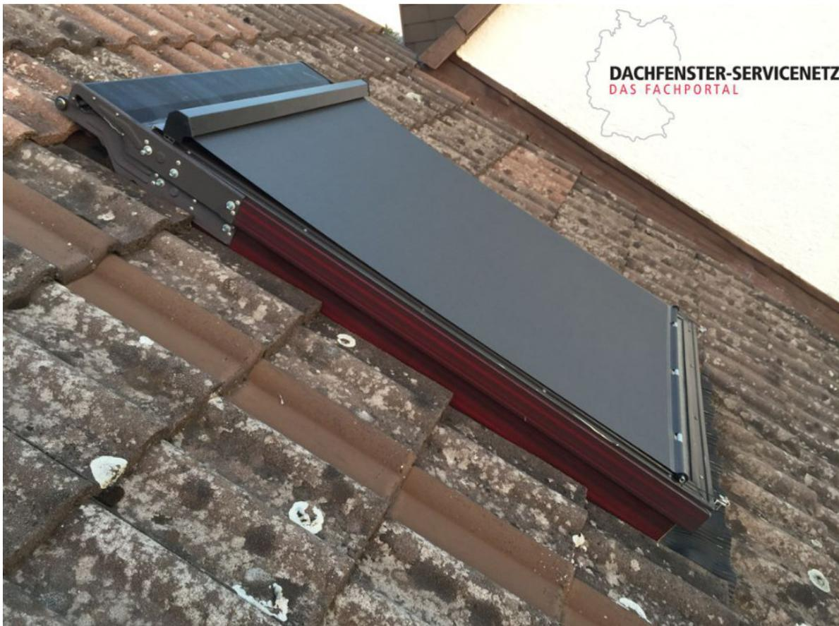
Der Kasten der Braas Netzmarkise wird am oberen Teil des Braas-Dachfenster befestigt mit 2 bis 3 (**Edelstahl-Schrauben 4,5x45, je nach Breite**) mitgelieferten Schrauben aus Edelstahl.
