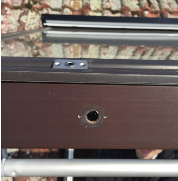
Die Schraubenlöcher der neuen Winkel müssen mit einem 3er mm Bohrer vorgebohrt werden (**ACHTUNG: nur maximal 2cm tief Bohren**), anschließend mit den 4 mitgelieferten **Edelstahl-Schrauben (3,9x16)** befestigt werden. **WICHTIG: Die neuen Winkel werden leicht schräg montiert, damit die Schnur leichter fährt.**
