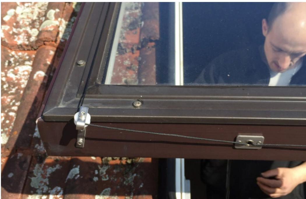
Innen muss der **Stopper über die Schnur** gezogen werden, in den man die Schnur leicht anzieht und einen dicken Knoten hinter dem Stopper macht, so dass dieser nicht mehr raus kann. **Die Schnur muss auf Spannung sitzen in dem die Netzmarkise ca. 5 cm aus dem Kasten ragt.**
