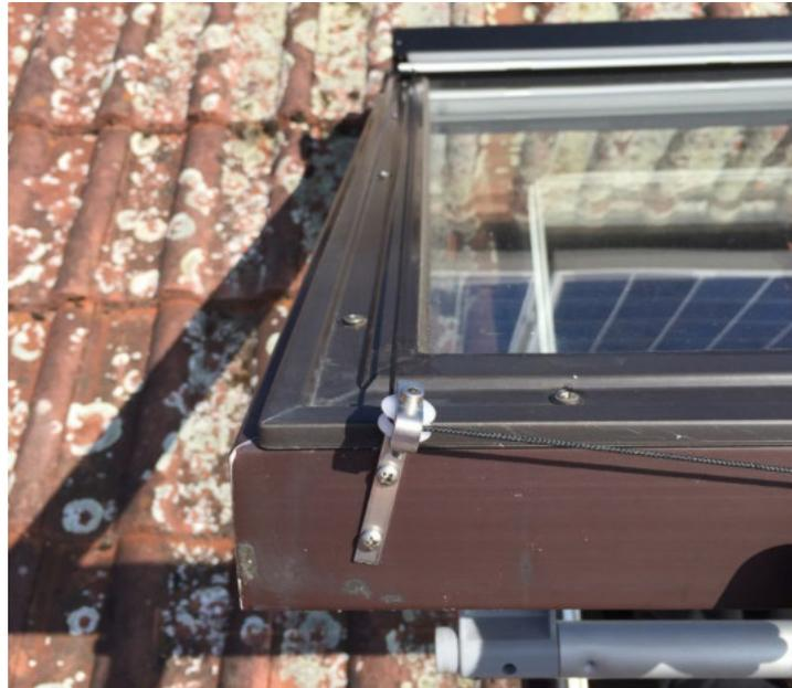
Jetzt muss die Schnur durchgeführt werden, die sich oben am Kasten befindet.
