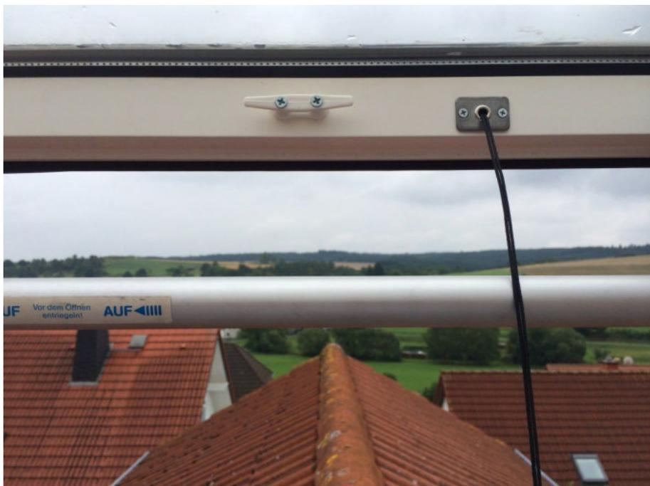
Die Schraubenlöcher der neuen **Edelstahl-Schnurdurchführung** muss nicht vorgebohrt werden, einfach mit den 2 mitgelieferten **Edelstahl-Schrauben (3,9x16)** befestigen.
